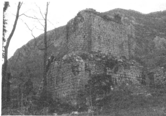
2. - Изглед цјелине са сјевероистока
