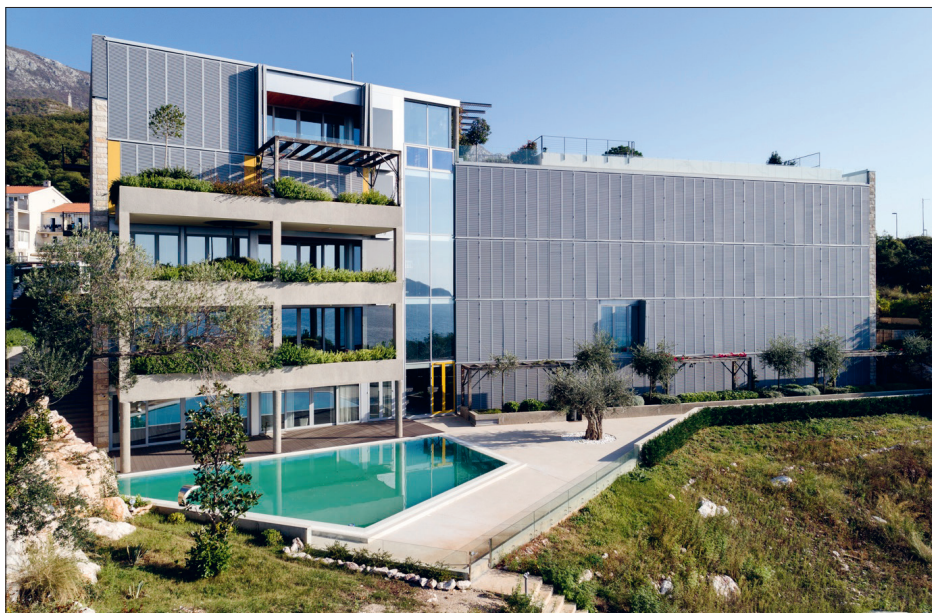
Slika 15. Hotel Kamenovo — fasada ka obali, iz projektne dokumentacije autora
