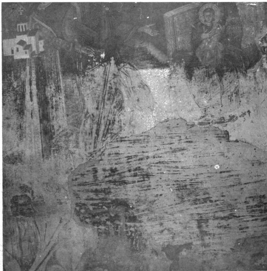
sl. 3. Izgled sjevernog zida paraklisa sv. Stefana sa vidnim oštećenjima živopisa u Donjoj zoni.
