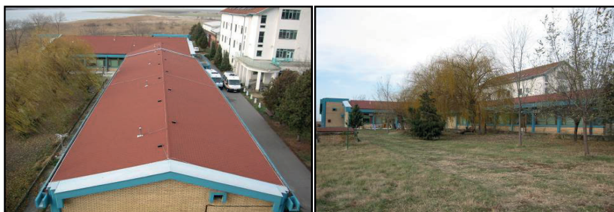
Slika 2. Paviljon 8 levo, ugao nagiba krova 17 0 , površina 240 m 2
