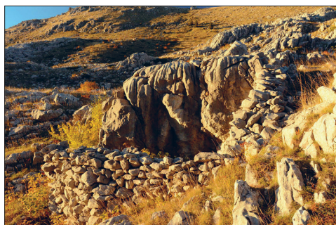
Sl. 9. primjeri korištenja postojeće stijene kao dijela zida. Donji Rikavac, Studenica, Momonjevo
