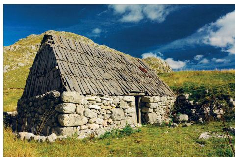
Sl. 7. konstrukcije krovova na 4, 3 i 2 vode. Mokra, Rupa Mičkova i donji katun Dučića u Gornjem Rikavcu
