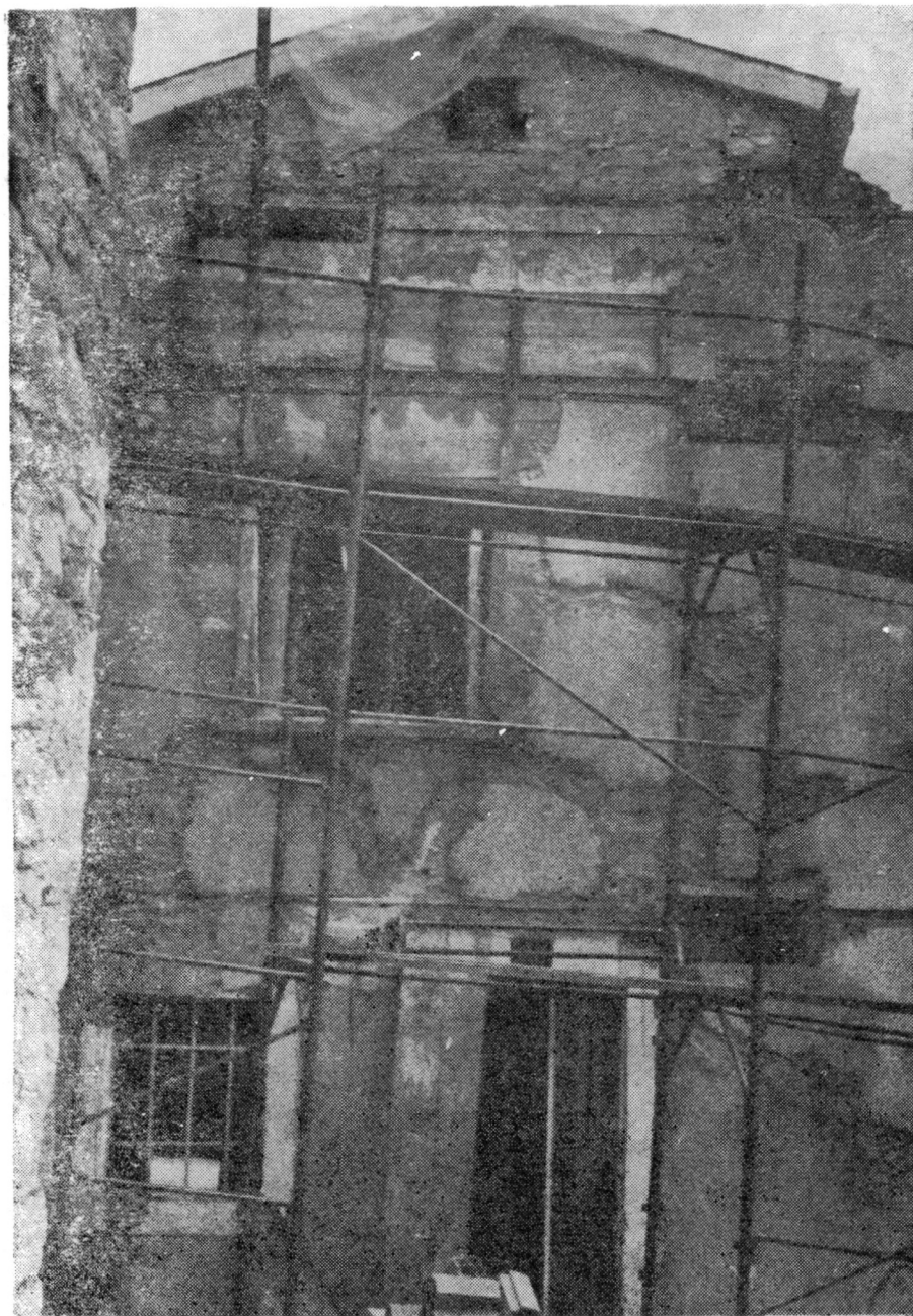
Sl. 8: Sanirana i ojačana kamena zgrada u Luseveri, Italija, posle zemljotresa u septembru 1976. godine
