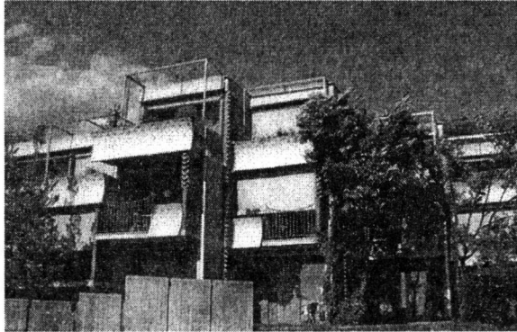
Slika 2. – “Omekšavanje” mase objekta povlačenjem fasade nadgrađenog sprata
