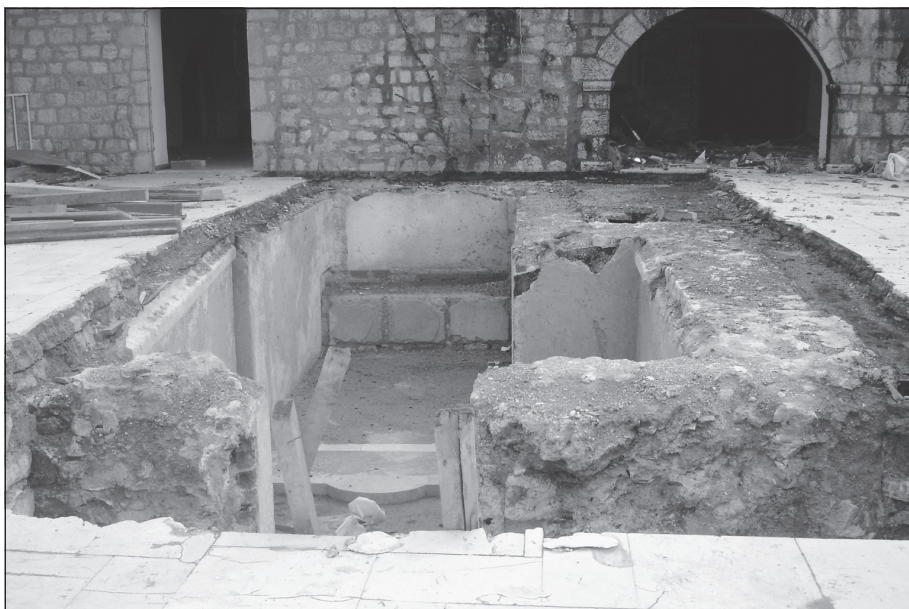
Сл. 3. Изглед локалитета након извођења припремних радова
