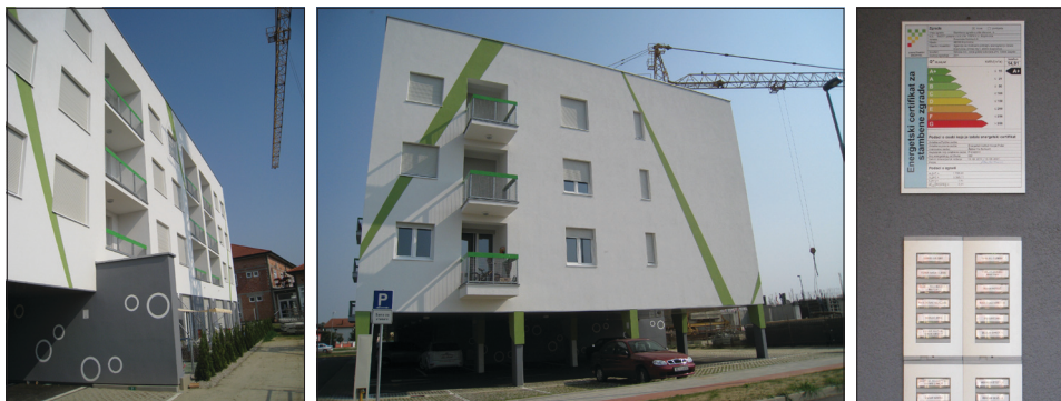
Slika 3. Višestambena zgrada u Koprivnici i energetski certifikat A+ na ulazu u zgradu
