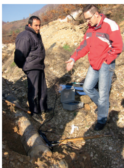
Sl. 4. Postavljanje ultra-zvučnog merača protoka vode
