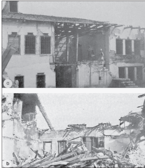
Slika 7. Efekti katastrofalnog zemljotresa na objektima u Skadru, u zemljotresu koji se dogodio 1905. godine u neposrednoj okolini Skadra, sa magnitudom 6.6
