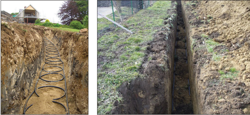
Slika 12. Modeli postavljanja cijevi u spirali i na stalnom razmaku
