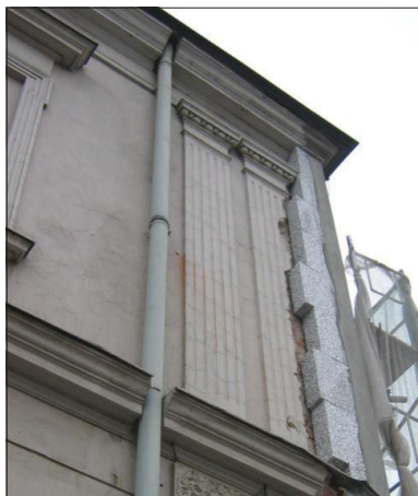
Slika 1. Primjena spoljašnje toplotne izolacije kao potencijalni konflikt u slučaju istorijskih zgrada
