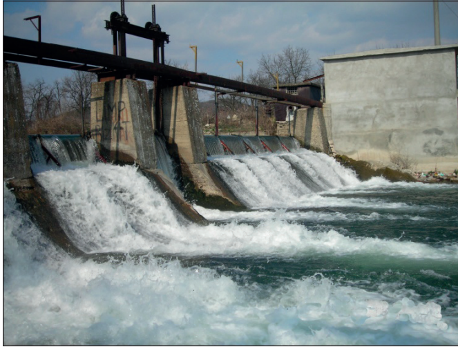
Slika 2. Fotografija sagrađene MHE i postojeće brane sa dograđenim ustavama na njoj
