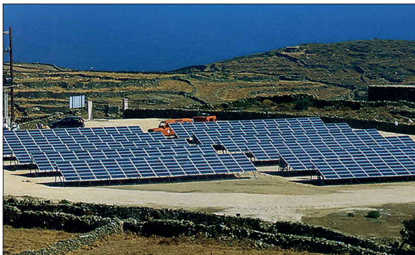
Slika 3. Solarna elektrana snage 60 kWp na grčkom ostrvu Sifnos
