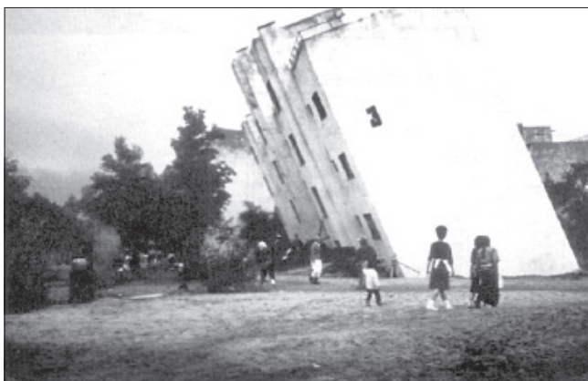
Sl. 8. Zgrada koja je potonula i nagnuta usled likvifikacije tla u Niagati zemljotres 1964. ( Handbook on Liquefaction Remediation of Reclaimed Land 1997 )
