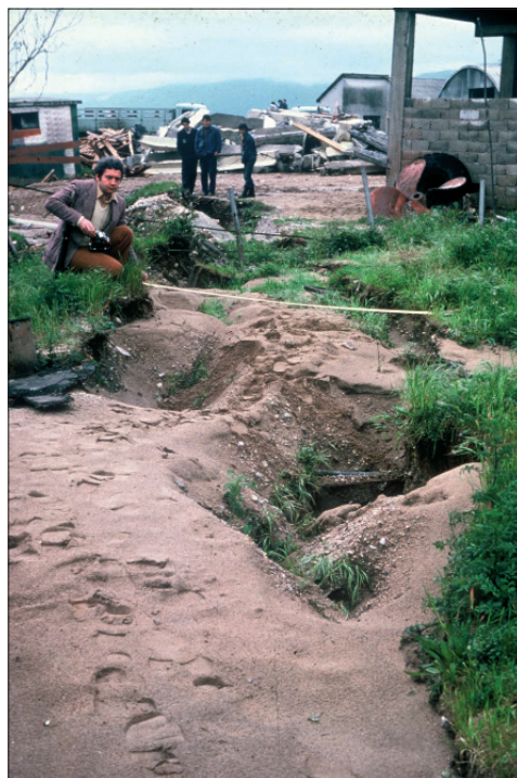
Sl. 9. Bijela, likvificirani pijesak izbija duž pukotine širine preko dva metra
