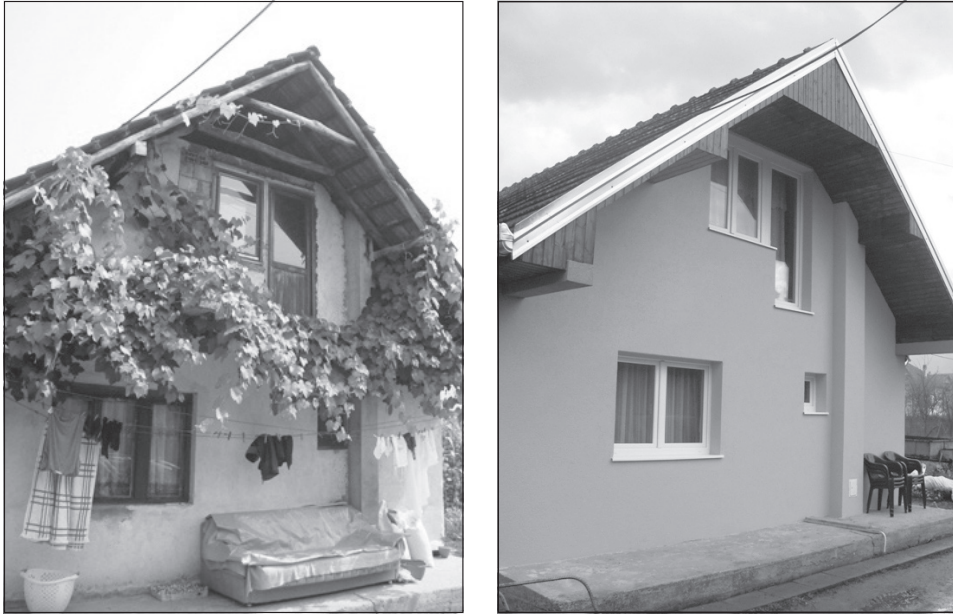
Slika 1: Nelegalni objekat prije i nakon rekonstrukcije
