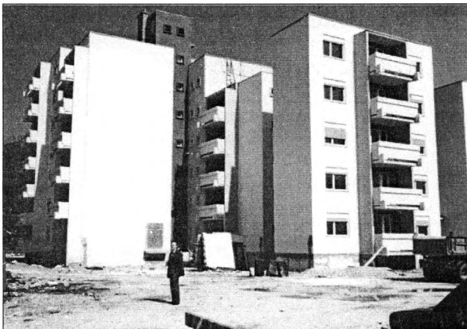
Slika 8. Stambeni objekti u Baru u montažnom krupnopanelnom sistemu: nakon zemljotresa sa minimalnim oštećenjima.
