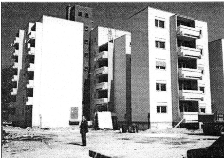
Slika 8. Stambeni objekti u Baru u montažnom krupnopanelnom sistemu: nakon zemljotresa sa minimalnim oštećenjima.
