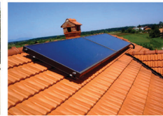
Pločasti kolektori u vodoravnoj izvedbi, Karlovac
