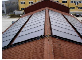
Pločasti kolektori u vodoravnoj izvedbi, Karlovac
