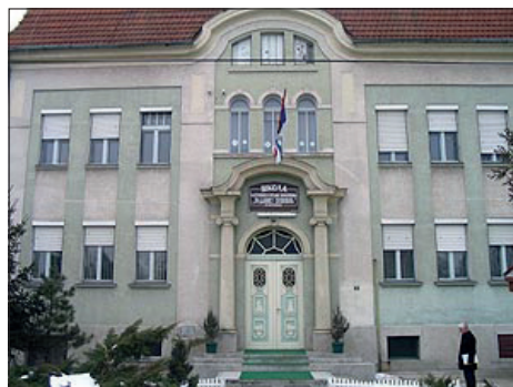
Slika 2. Zgrada škole „Radivoj Popović” u Sremskoj Mitrovici
